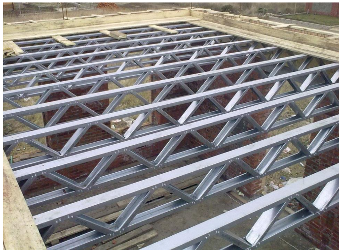
Рис. 2. Кроквяна ферма із профілів ЛСТК
