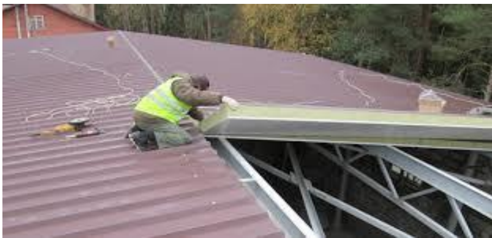
Рис. 14. Монтаж сендвіч-панелі за двопрольотною схемою
