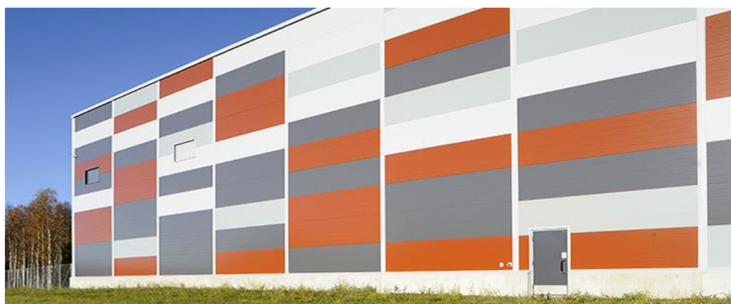
Рис. 10. Фасад із стінових сендвіч-панелей
