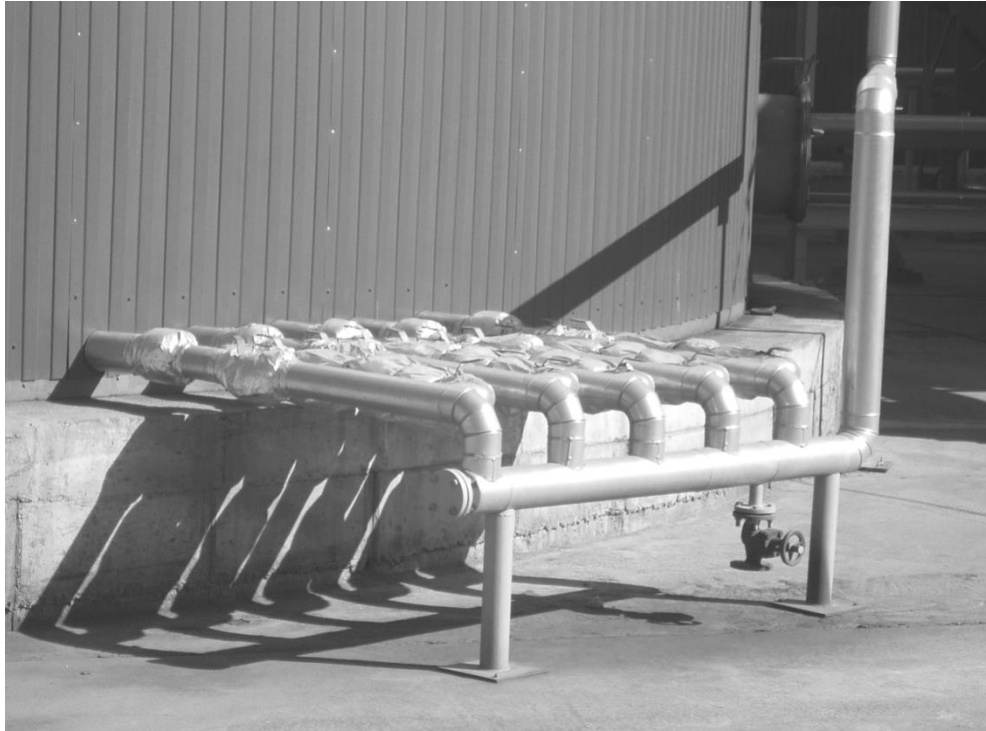
Рис.1.2. Подача пара для внутрішнього підігріву продукту
