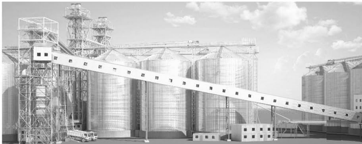
Рис. 1. Загальний вигляд конвеєрної галереї
