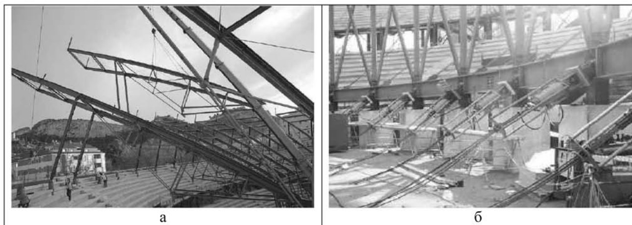
Рис.8. Елементи куполу перед початком підйому:
