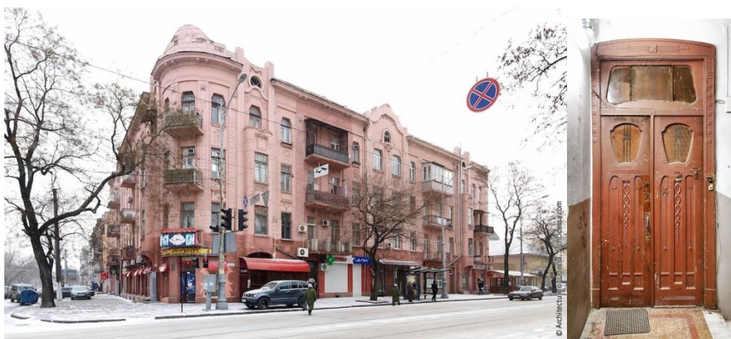
Рис. 5. Одесса. ул. Большая Арнаутская, 99. Доходный дом Кориман. Общий вид. Дверь квартиры. Тип здания: доходный дом. Стиль: северный модерн. Архитекторы: А. И. Гольцвурм, Ф. Э. Кюннер, 1913 г. Статус: памятник архитектуры местного значения [5]
