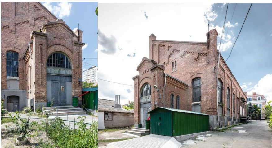
Рис. 4. Одесса. Комплекс аркадийской подстанции Одесского трамвая. Архитектор: А. Б. Минкус, статус: не определен, первая половина 1910-х гг. [5]
