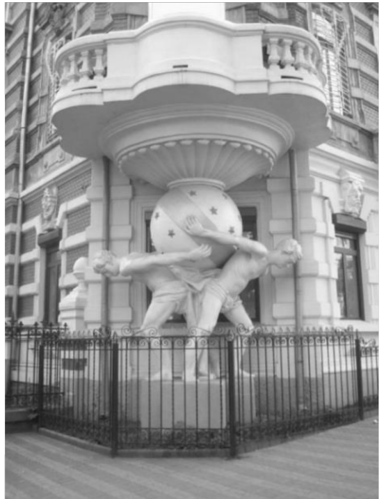
Рис.2.2. Атланты дома по ул. Гоголя, 5-7. После ремонтных работ (фото автора)
