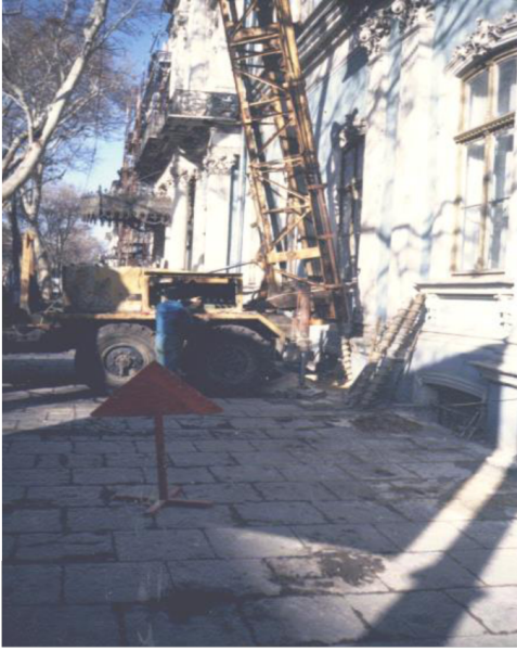
Рис. 2. Фрагменты устройства наклонных свай усиления с уровня дневной поверхности и пола подвала здания
