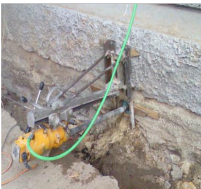
Рис.3. Проектные решения и отдельные этапы выполнения работ по усилению фундаментов здания Гимназии №1
