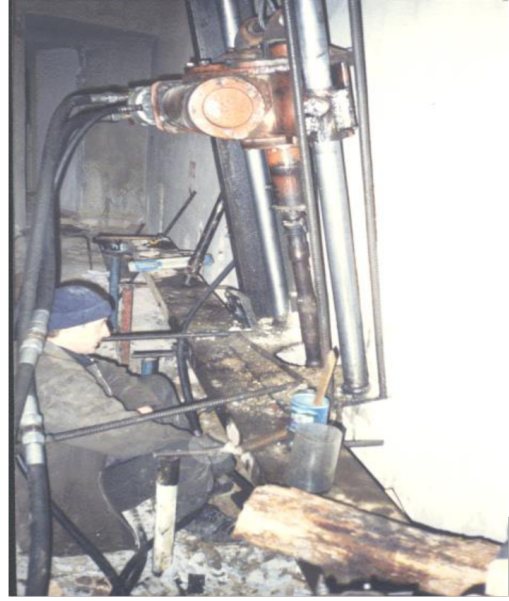
Рис. 2. Фрагменты устройства наклонных свай усиления с уровня дневной поверхности и пола подвала здания
