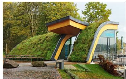
НАКЛОННАЯ ЗЕЛЕНАЯ КРОВЛЯ
