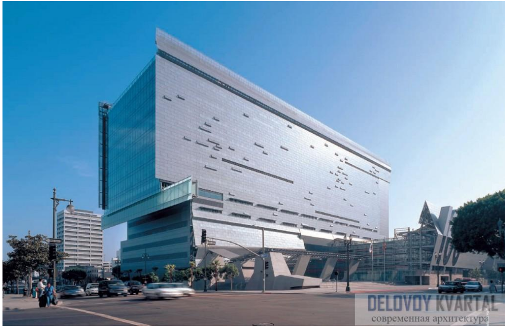
Рис.13. Приклад простий композиції зі складним фасадним склінням. Будівля Калтранс в Лос-Анджелесі (загальний вигляд)
