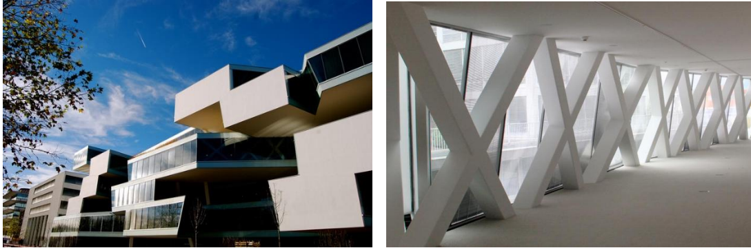
Мал.3. Бізнес-центр «Actelion Business Center», Альшвіль, Швейцарія. 2010р.
