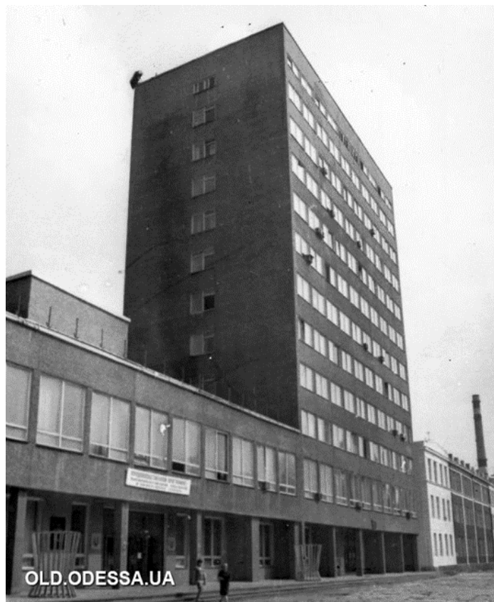
Рис. 4 б. «Одессельмаш» (ЗОР), Корпус постройки 1970 г
