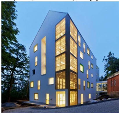
Рис. 6. Реабилитационный центр Батъяны Ласло в Будапеште, Венгрия арх. Студия А4, 2015 г.
