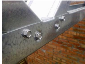
Рис. 5. Фрагмент ферми з вузовими з'єднаннями 1 – верхній пояс; 2 – нижній пояс; 4 – розкоси
