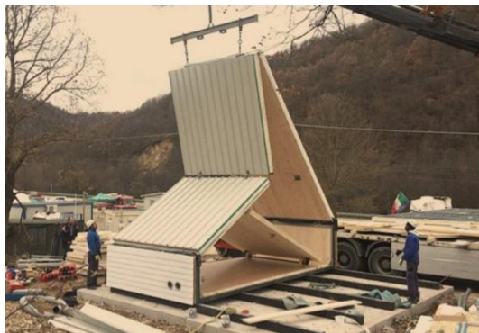
Рис. 1. Процесс разгрузки и монтажа дома M.A.Di
