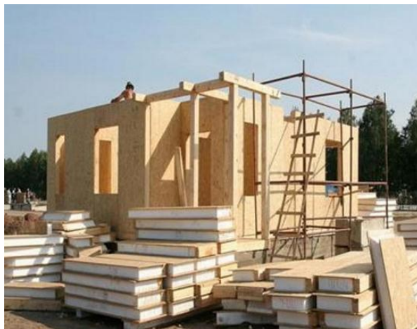
Рис. 2. Строительство дома с использованием структурных изолированных панелей
