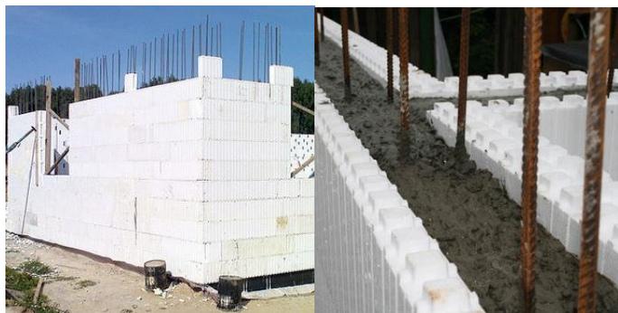
Рис. 3. Строительство из термоблоков
