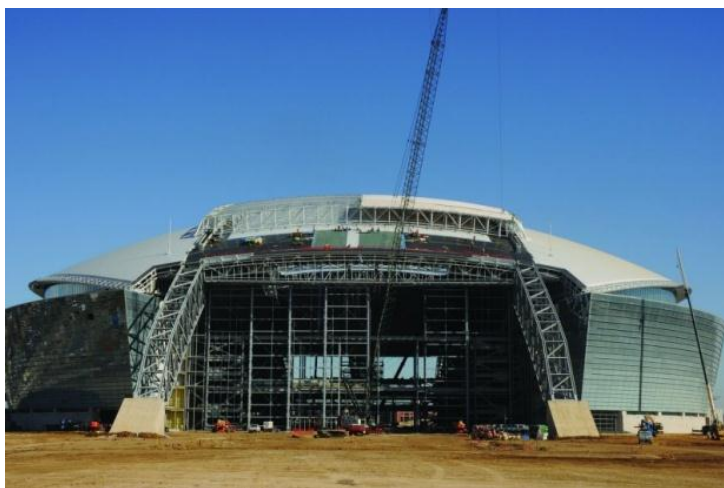
Рис. 2. Монтаж частини каркасу трансформованої плити в проектне положення
