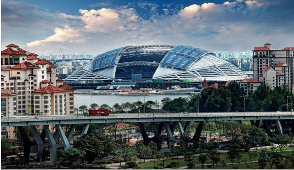
Рис. 3. Національний стадіон у Сінгапурі з відкритим отвором покриття
