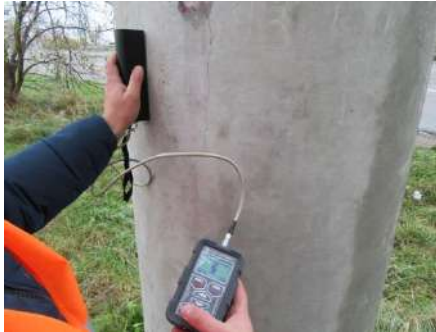
Рис. 2. Визначення захисного шару бетону стояка шляхопроводу.
