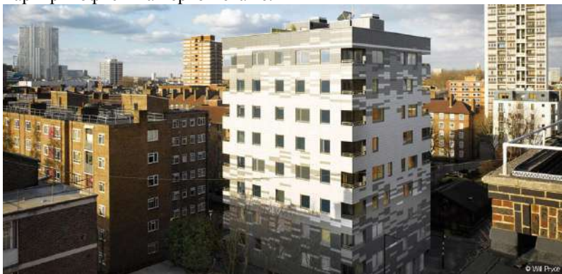
Рис. 4. Многоэтажные здания из дерева, Лондон.
