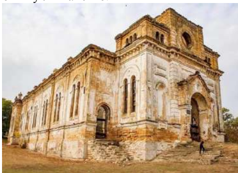
Рис. 2. Загальний вид фасаду.
