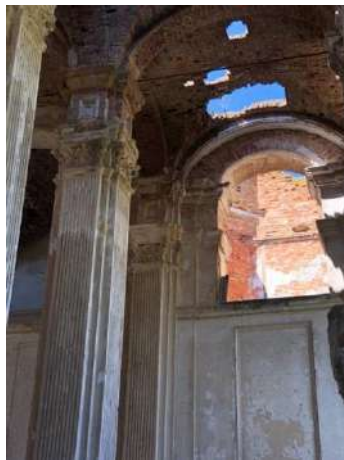
Рис. 3. Загальний стан несучих конструкцій: колон та цегляних сводів.
