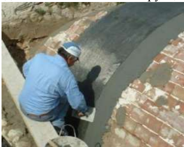
Рис. 5. Посилення пошкоджених цегляних сводів і аркових конструкцій історичних будівель.
