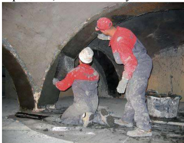
Рис. 5. Посилення пошкоджених цегляних сводів і аркових конструкцій історичних будівель.
