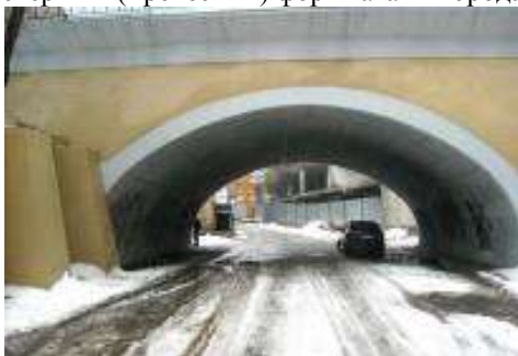
Рис. 2. Вид моста после реконструкции.
