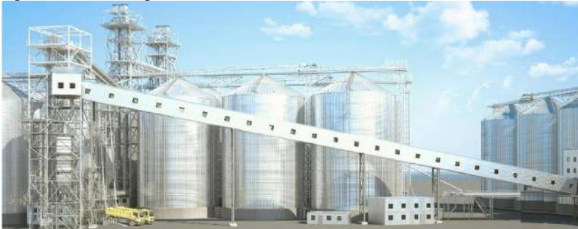
Рис. 1. Загальний вигляд конвеєрної галереї.
