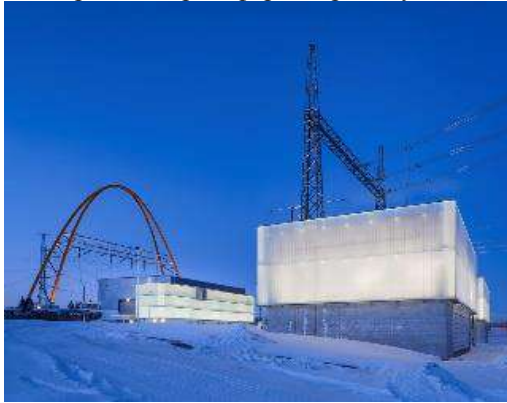
Рис. 2. Länssalms Power Station. Ванда, Фінляндія. Арх. Parviainen Architects. 2018 р. Перспектива [5].
