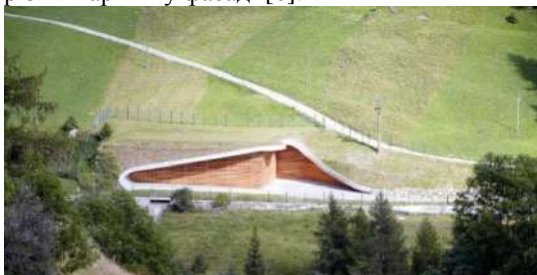
Рис. 4. Hydroelectric Power Station Punibach. Південний Тироль.
