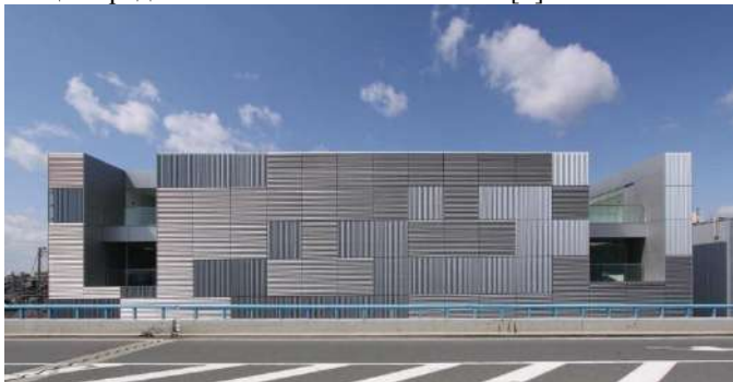
Рис. 3. Здание фармацевтической фабрики г. Осака Японии, бюро «Takashi Yamaguchi & Associates».
