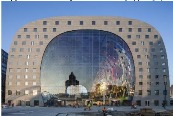
Рис. 4. Ринок Марктхал, Роттердам. Найбільший вантовий (різновид спайдерного) скляний фасад у Європі
