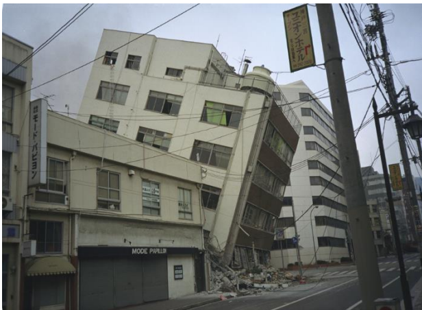
Фото 1. Руйнування каркасної будівлі по крайніх несучих колонах від сейсмічного впливу (приклад 1)
